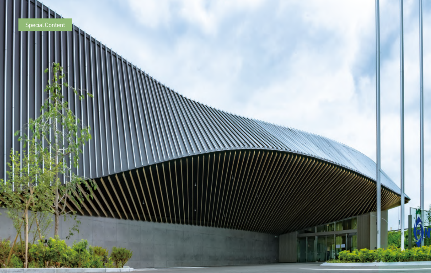
建物の正面外観(ファサード)
