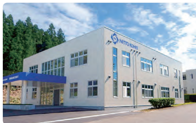
白河日東工器 新事務棟
