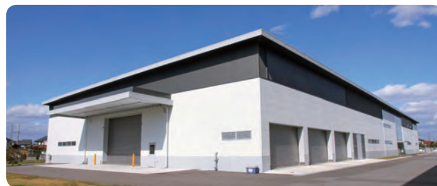
栃木日東工器 第7工場
