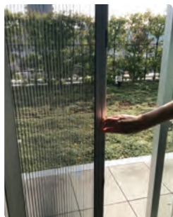
新設した網戸
