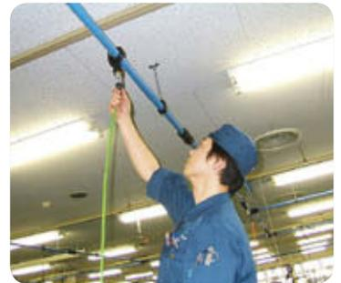
本来業務の中から具体的な目的・目標を定め、コンプレッサのエア配管漏れ箇所の改善、非稼働設備の主電源の遮断による待機電力の削減などエネルギー効率の向上に努めています。それと併行して、C-TPM活動による不良率の低減を図り、環境マネジメントシステムとの相乗効果により経費削減を実現しています。
