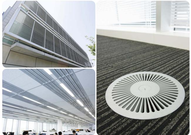
壁面の輻射熱を約90%カットするルーバー（左上）、人やパソコンの熱を緩和する天井の空調設備（左下）、アンダーフロア空調（右）
