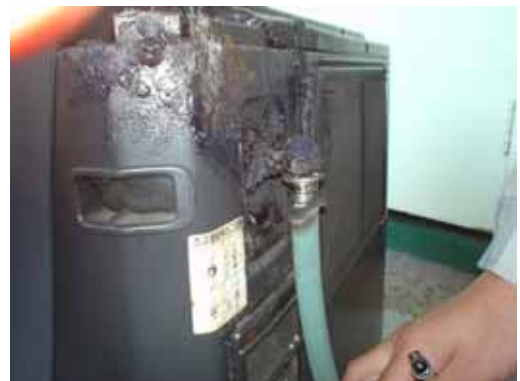
《ガス機器にゴム管を直接接続した場合》
